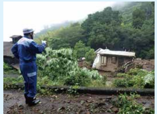
小田原市内の盛土関連での点検完了箇所
