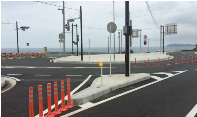
《渋滞が解消された国道135号線根府川合流部》
