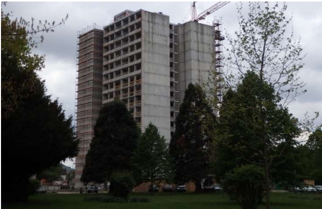
《高气密高断熱住宅へとリノベーション中の高層住宅》
