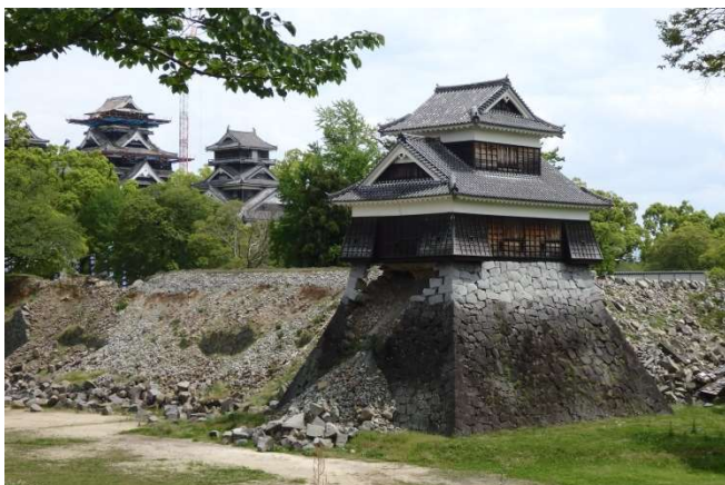
《石垣が崩壊した熊本城、後ろに見える天守は再建工事中》
